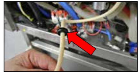
Grommet on delime hose.
