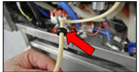
Passe-fil sur le tuyau de détartrage.
