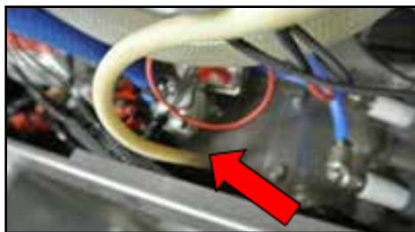
Passe-fil installé dans le trou.
